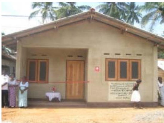
la casa completata
