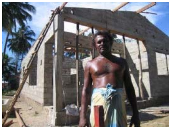
io davanti alla mia casa in costruzione
